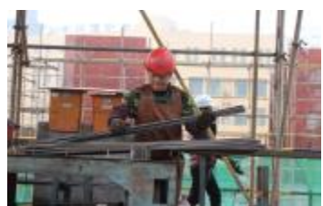
安徽省职业病防治院综合业务大楼项目部开工前检查设备
